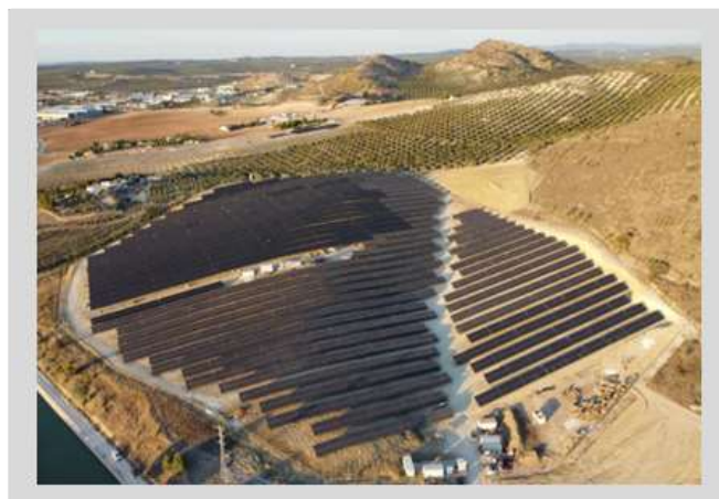
Plantas en Puente Genil (Córdoba) – potencia 5,41 y 1,64 MWp
