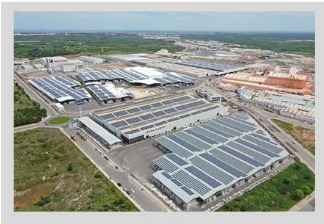
Instalación en Onda (Castellón) – potencia 13,2 MWp
