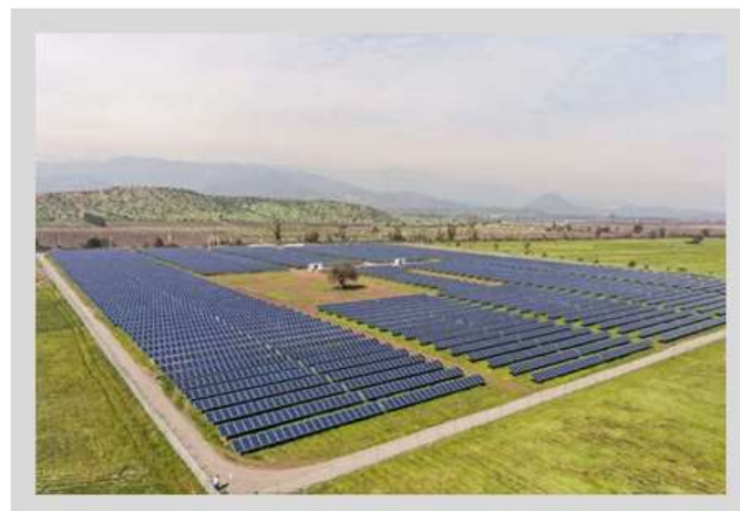
Instalación en Colina (R. Metropolitana) – potencia 3,6 MWp
