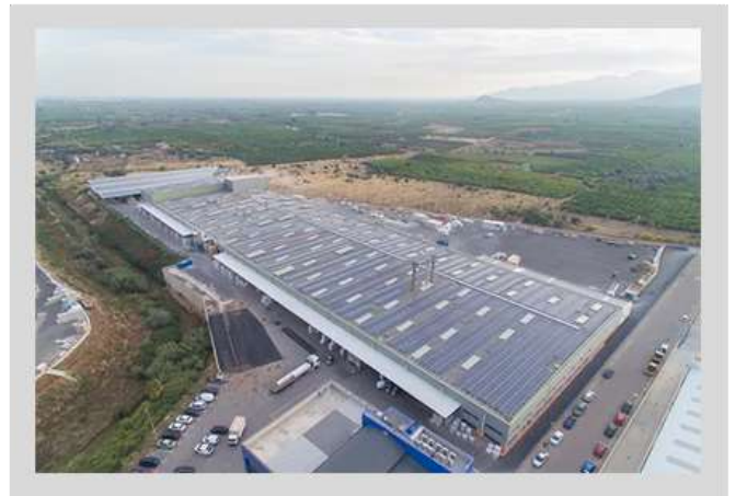
Instalación en Villareal (Castellón) – potencia 3,1 MWp
