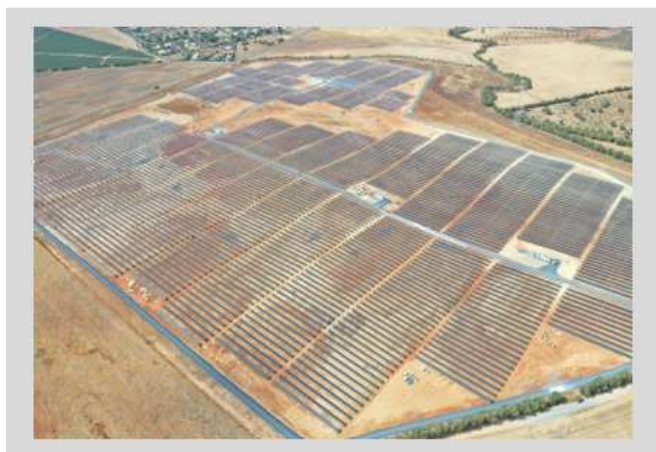
Planta en Gibraleón (Huelva) – potencia 26,1 MWp
